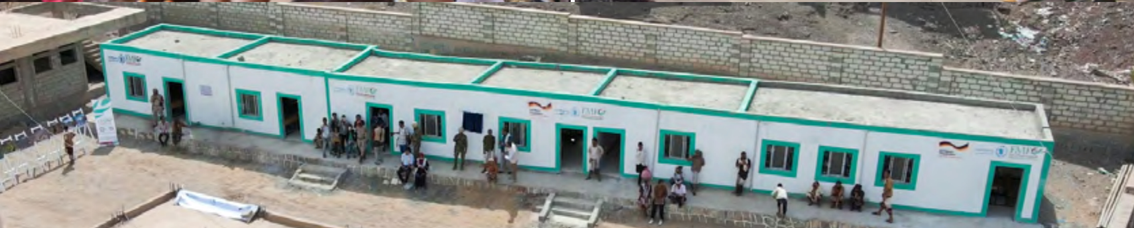
إعادة تأهيل 6 فصول دراسية بمدرسة خالد ابن الوليد بمديرية الملاح محافظة لحج حيث اتم إعادة افتتاحها بحضور وفد رفيع من الخارجية الألمانية والوزارة الاتحادية الألمانية للتعاون الاقتصادي والتنمية وبرنامج الأغذية العالمي Rehabilitation of 6 classrooms at Khaled Ibn Al-Walid School in Al-Mallah District, Lahj Governorate, where it was reopened in the presence of a delegation from the German Foreign Ministry and the Federal Ministry of Economic Cooperation and Development (BMZ)
