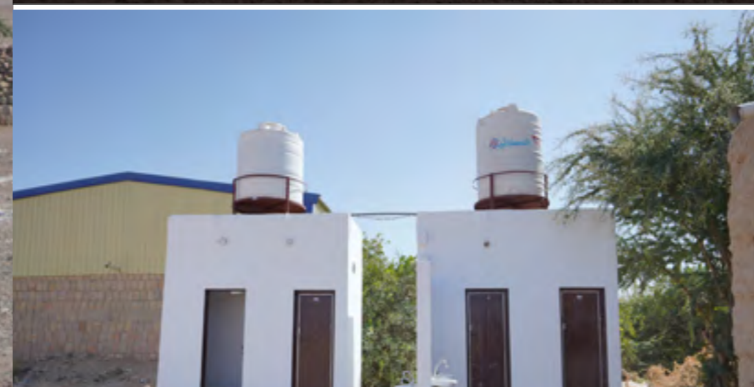
بناء أربعة حمامات في مدرسة بدر الكبرى مخيم النقيعاء - محافظة مأرب Building four bathrooms in Badr Al-Kubra School, Al-Naqe'a Camp, Marib Governorate
