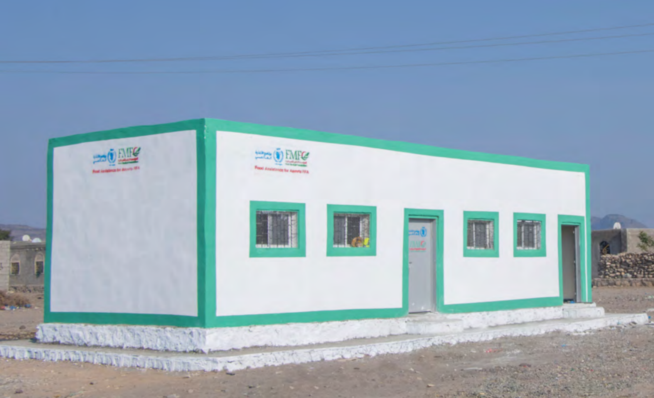
بناء فصلين في مدرسة حبيل سويدا بمديرية المسيمير - محافظة لحج Building two classrooms in Habel Al-Sweida School in Al-Musaymir District - Lahj Governorate
